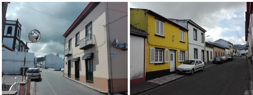
Figura 12. Tecido edificado na ARU de Santa Bárbara
