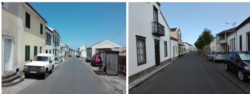
Figura 16. Condições de circulação pedonal na Rua da Igreja e na Rua Nossa Sr. a das Vitórias Fonte: SPI
