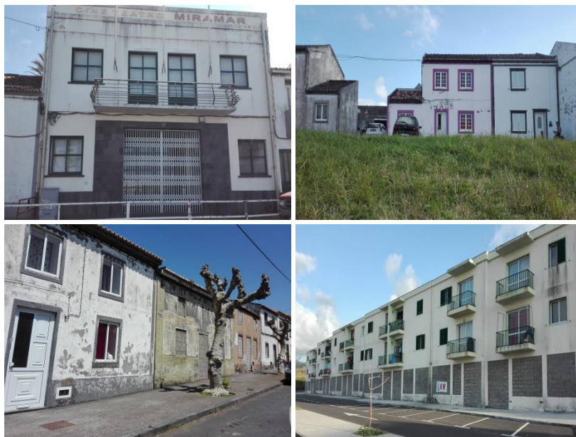
Figura 14. Diferentes estados de conservação do edifício da ARU da Vila de Rabo de Peixe
