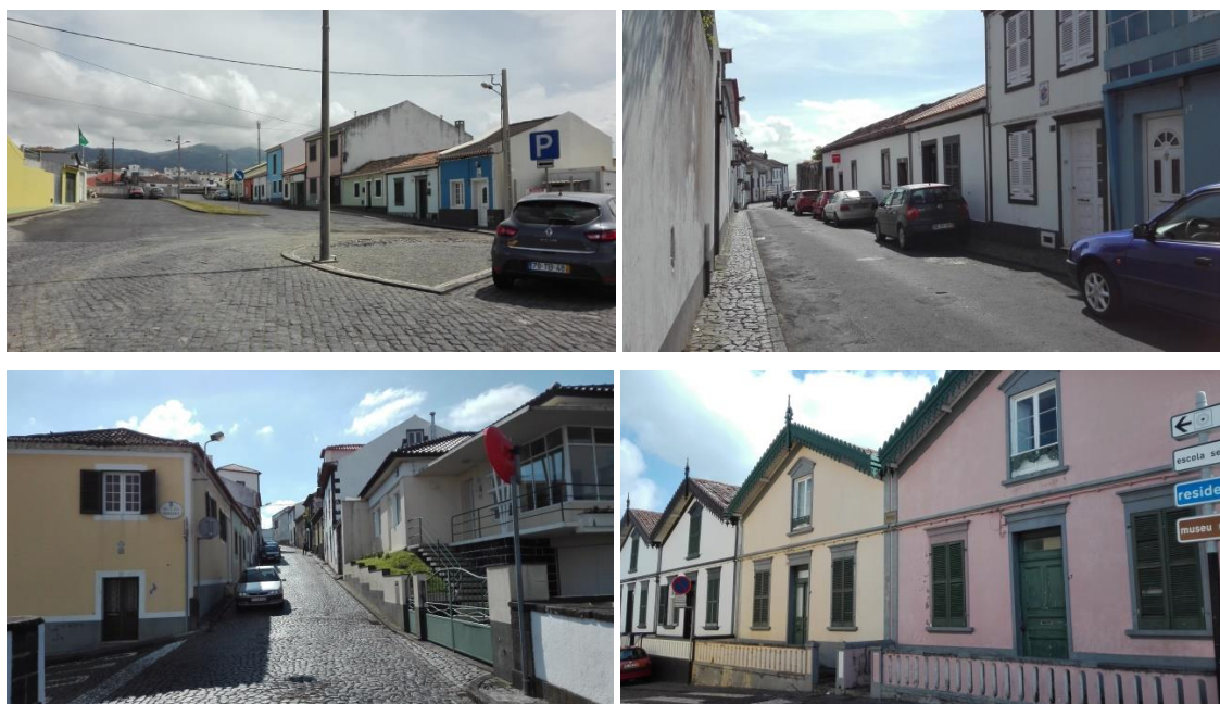
Figura 16. Tecido edificado na ARU da Cidade da Ribeira Grande
