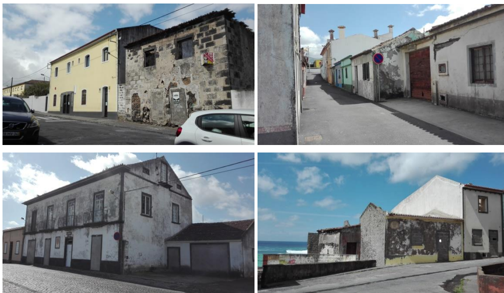
Figura 19. Exemplos de edifícios em mau estado de conservação ou ruína na ARU da Ribeira Grande
