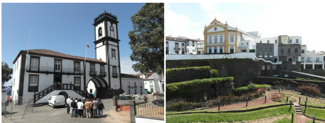
Figura 130. Edifício dos Paços do Concelho e Teatro Ribeiragrandense.
