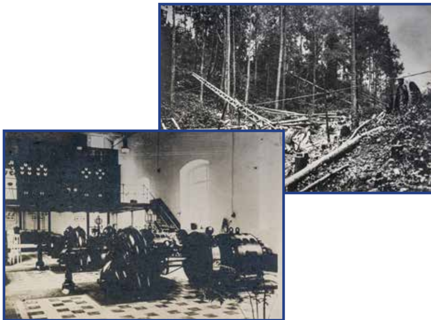
Construção e instalação dos postes de luz a partir da central hidroelétrica da Ribeira Grande, 1ª metade do século 20.
