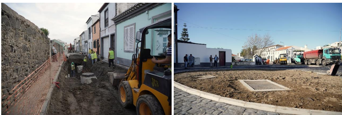
Figura 6. Construção de redes de saneamento e drenagem no Concelho
