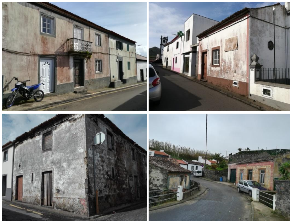
Figura 93. Exemplos do tecido edificado degradado no concelho da Ribeira Grande
